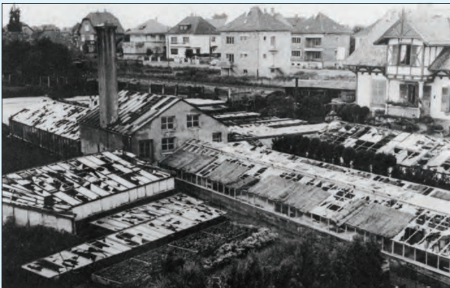
Vue prise depuis la rue Jeanne d'Arc, avec les dégâts causés par l'orage de grêle du 11 Août 1958 et, à l'arrière plan, les immeubles en construction de la Rue Bœcklin.
