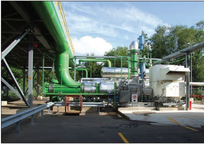
Usine géothermique à Landau (Allemagne)
