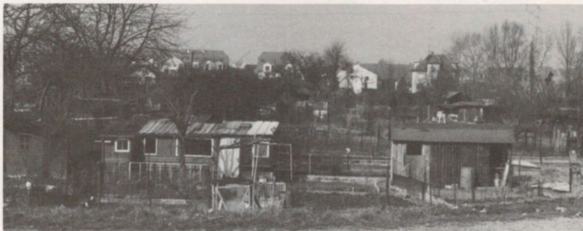
Dos aux cuves, on se rend mieux compte de la proximité des zones d'habitation.
