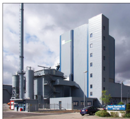
La centrale biomasse de la papeterie Koehler de Kehl
